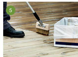
Bona Decking Oil auftragen
