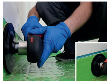
Unebene Flächen und schwer zugängliche Ecken stellen kein Problem dar.
